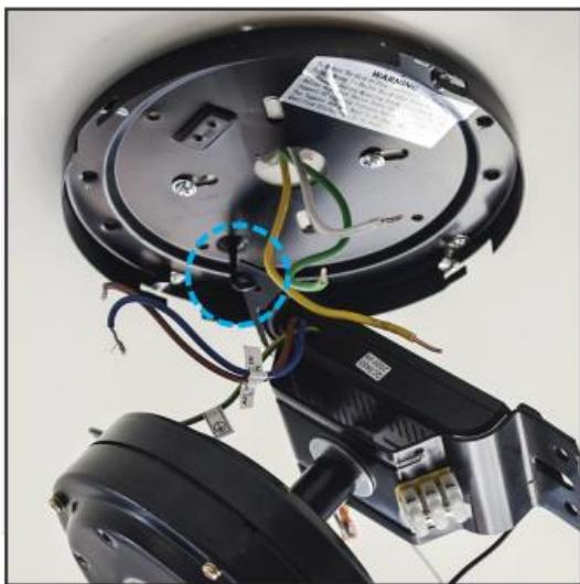
3. Ο κινητήρας είναι κρεμασμένος στο γάντζο J του συρόμενου δίσκου του βραχίονα στήριξης, έτοιμο για καλωδίωση.
