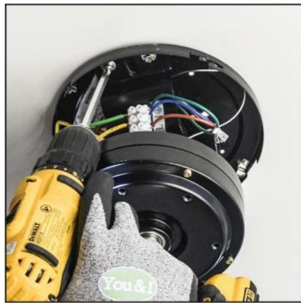
5. Σηκώστε προσεκτικά τη μονάδα του μοτέρ μέχρι το συρόμενο δίσκο του βραχίονα στήριξης . Τοποθετήστε τη μονάδα του μοτέρ χρησιμοποιώντας τις 4 βίδες στερέωσης στο συρόμενο δίσκο του βραχίονα στήριξης .
